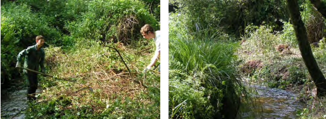
Entretien dans le cadre d'un chantier école. (Cours d'eau le St Jean)
